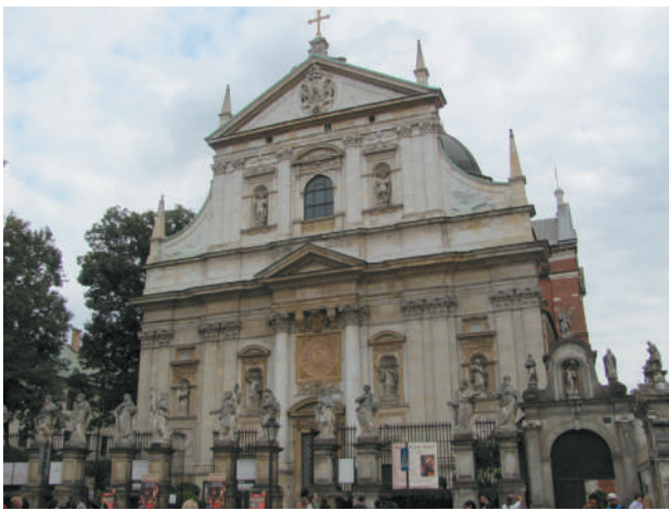
Bazyliki Królewskiej strzeże 12 apostołów. Jej podziemia - wielowiekowe krypty, piwnice i pustki, a także teren przykościelnego dziedzińca, były przedmiotem prac geodezyjno-geologicznych, inwentaryzacyjnych i naukowych
