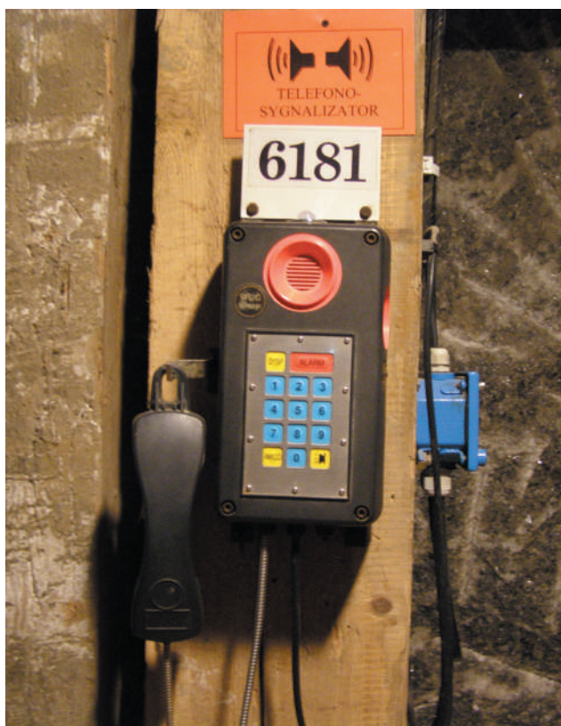
Rys. 5. System łączności Star 80, obejmujący ponad trzydzieści aparatów zlokalizowanych w wyrobiskach objętych ruchem turystycznym
