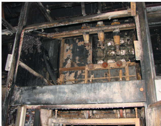
Rys. 4. Odłącznik szyn w polu, w którym doszło do zwarcia
