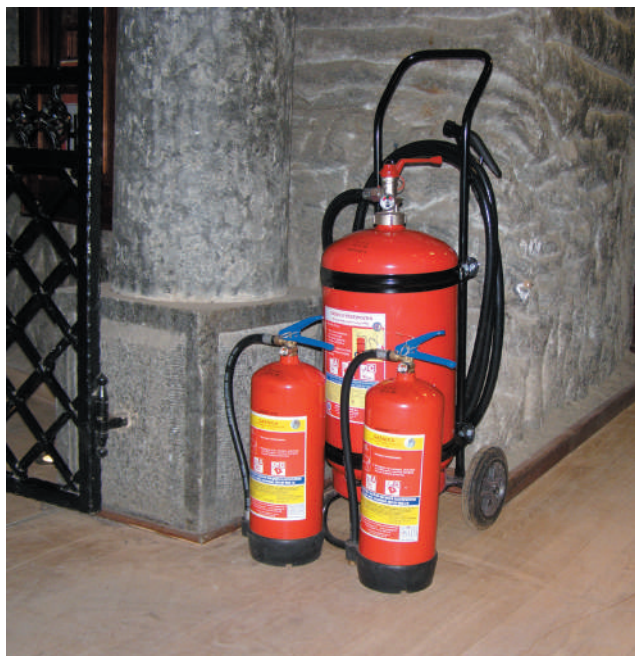
Rys. 3. Dodatkowe, proszkowe agregaty gaśnicze rozmieszczone w miejscach szczególnie narażonych na wystąpienie pożarów
