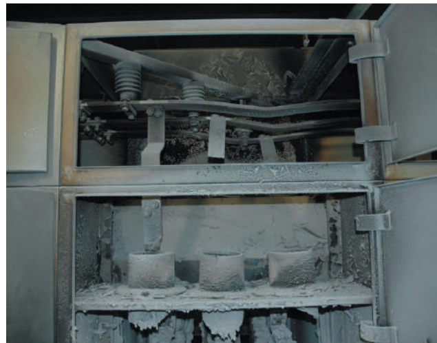
Rys. 5. Miejsce powstania zwarcia: przyłącze szyn
