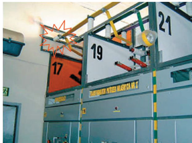
Rys. 7 i 8. Widok rozdzielnic po zadziałaniu zabezpieczeń
