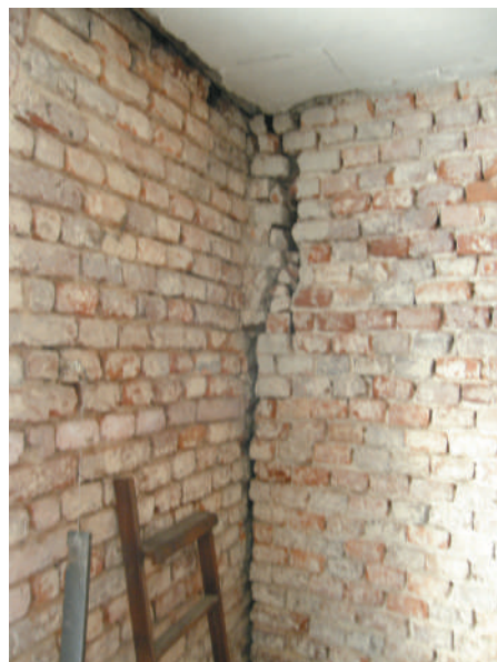
Fot. 1. Budynek wykazujący uszkodzenia świadczące o przeciążeniu konstrukcji w wyniku nadmiernego wchylenia: a) widok ogólny; b) odspojenie najsilniej wychylonej ściany zewnętrznej od pozostałej części budynku
