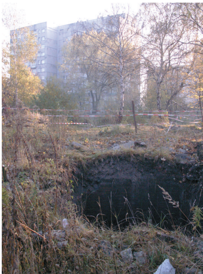
Rys. 2. Przekrój pionowy szybu Matylda III wraz z zaznaczonym, 36-metrowym ubytkiem zasypu oraz teren nad szymb Matylda III osiem dni po osunięciu materiału zasypowego (fot.: 22 X 2008 r.)
