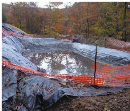
Rys. 4. Dół urobkowy z plastikową matą do składowania zwiercin i wody w miejscu otworu do formacji Marcellus Shale
