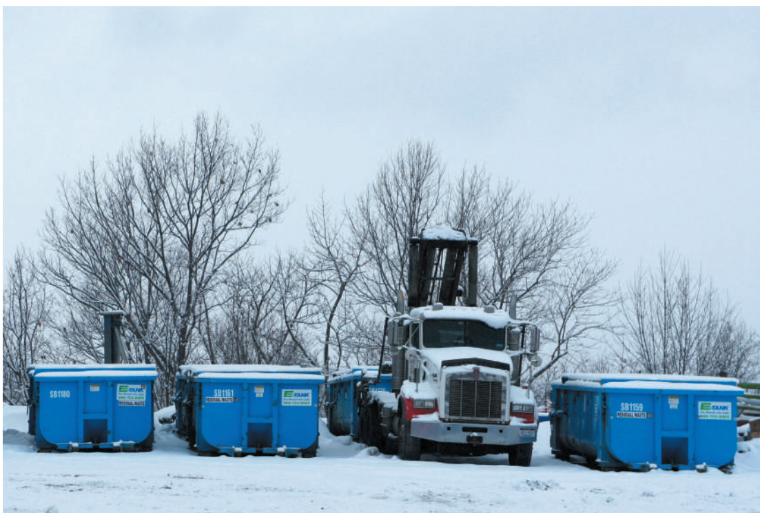
Rys. 3. Przewoźne zbiorniki stalowe systemu przygotowania płuczki w miejscu wiercenia otworu firmy Chesapeake Energy w rejonie Green Valey (USA); fot. M. Wądrozka
