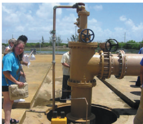
Rys. 5. Otwór iniekcyjny, którym można zatłoczyć płyny szczelinujące
