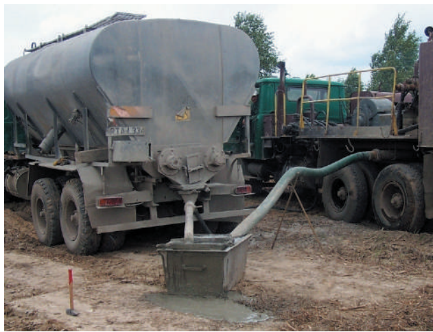
Rys. 16. Wypełnianie otworu tworzywem uszczelniającym
