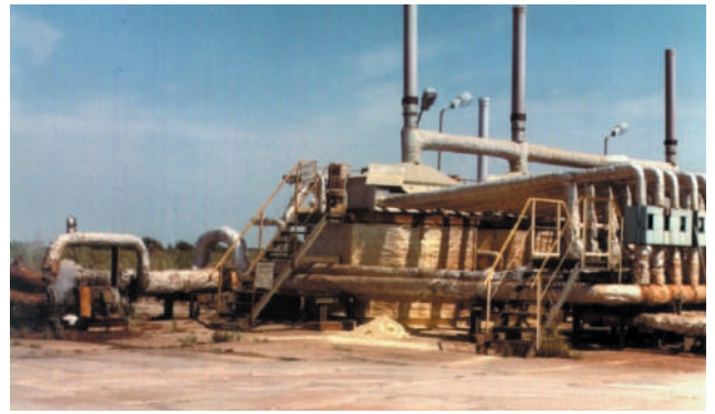
Rys. 4. Sterownia AKP Fig. 4. Control section AKP
