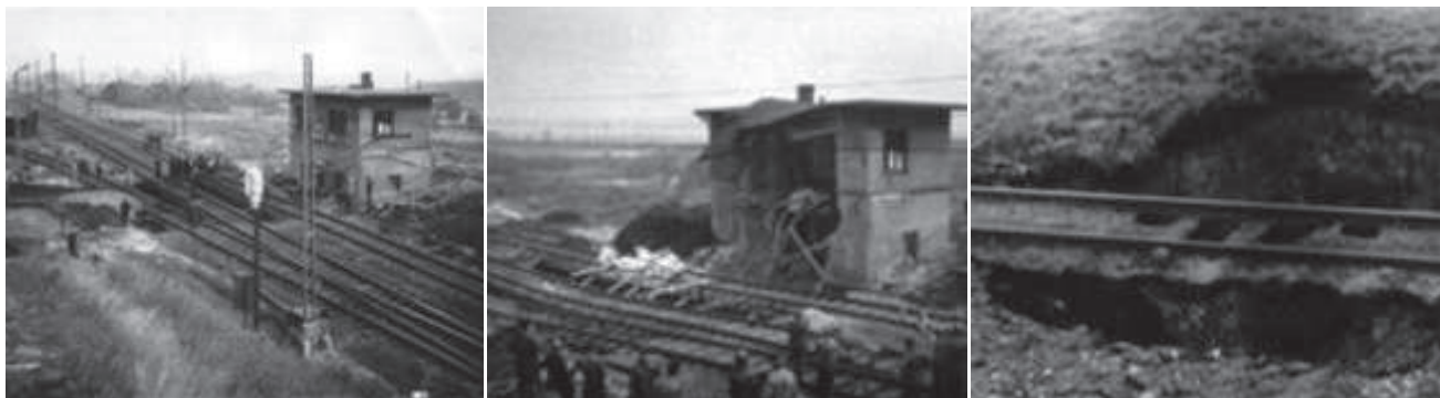
Rys. 10. Zapadlisko pod torami linii kolejowej Muchowiec-Zawiercie powstałe w 1968 r. na posterunku odgałęźnym Mieszko KWK „Mysłowice” (fot. F. Grabowski).
