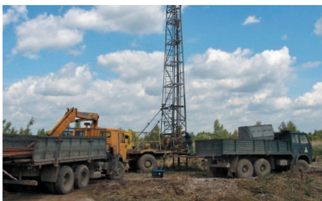
Rys. 15. Wyciąganie z otworu rur kolumn eksploatacyjnych
