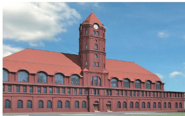
Rys. 9. Budynek cechowni KWK „Gliwice” po rewitalizacji Fig. 9. Pithead building of the “Gliwice” hard coal mine after revitalisation
