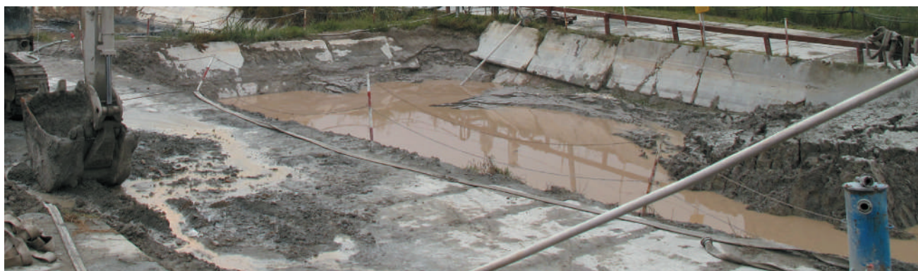
Rys. 1. Zestalanie urobku na terenie wyrobiska
