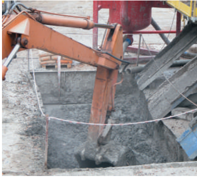
Rys. 2. Mieszanie urobku w zbiorniku na otworze
