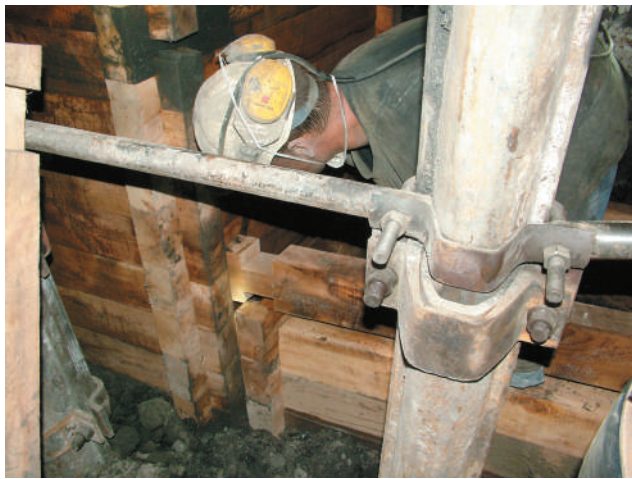
Fot. 1. Budowa kasztu – widok od strony chodnika
