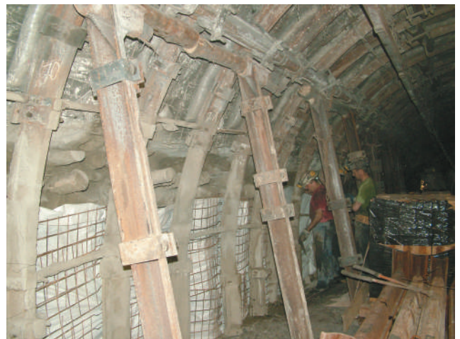
Fot. 2. Ocios chodnika po wypełnieniu kasztów
