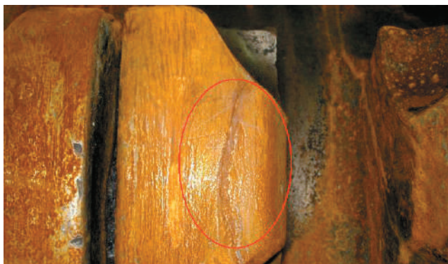
Rys. 3. Korozja naprężeniowa widoczna w miejscu pęknięcia zmęczeniowego zęba bębna łańcuchowego współwystępująca z niszczeniem zmęczeniowym
