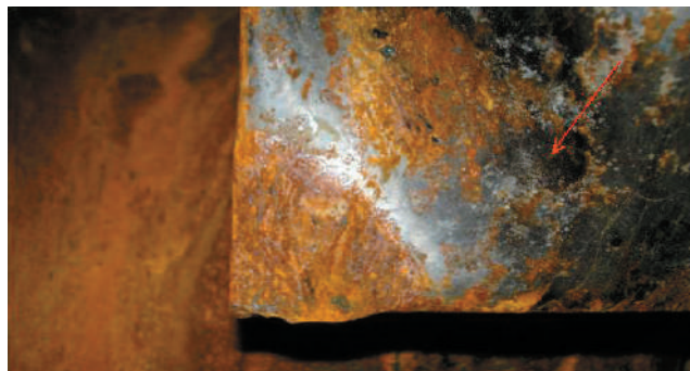
Rys. 2. Korozja wżerowa i ogólna zęba bębna łańcuchowego ze staliwa stopowego
