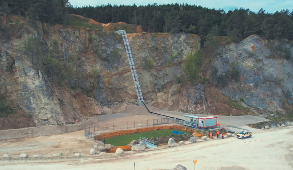
► Rys. 12. Pompownia wraz z rurociągiem odprowadzającym wody z odwodnienia wyrobisk do obiektu „Kacze Doły” (źródło: opracowanie własne ZG „Kujawy”)
